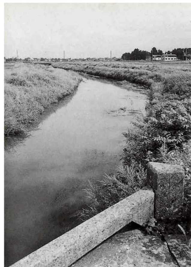
▲現在の須川釜ヶ島橋付近から下流を望む
