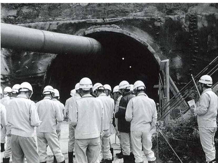
仮称大積トンネル
