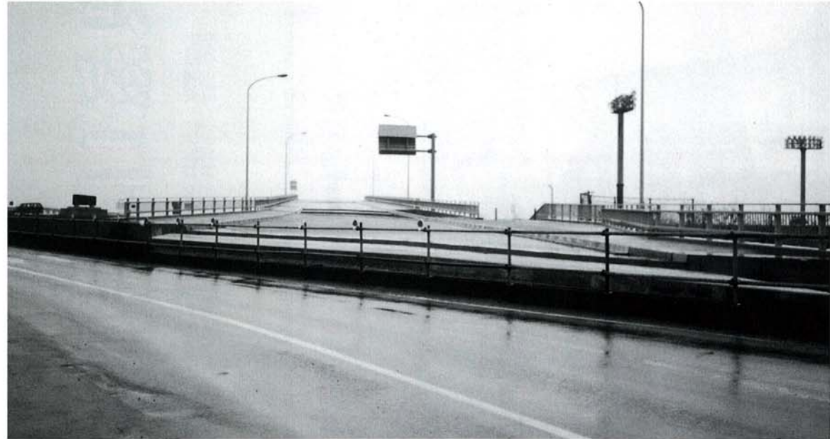
越路橋左岸側取付け工事中
