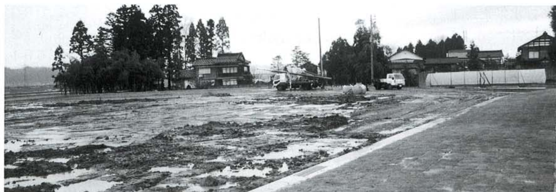
完成した岩野地区工場用地
