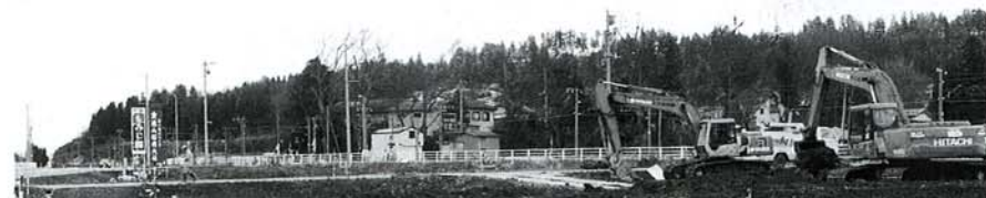
飯塚中島宅地造成工事始まる
