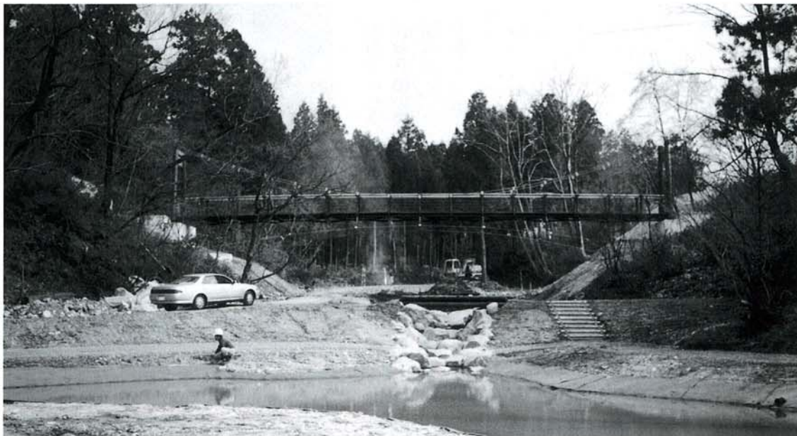
越路自然公園工事中 吊り橋完了
