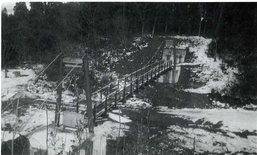
越路原自然公園整備中のつり橋
