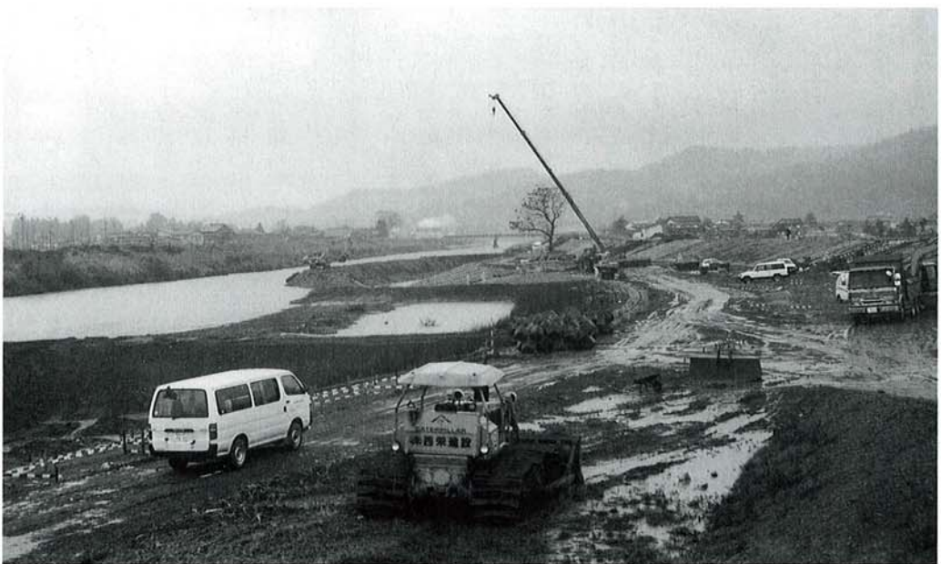
工事中の飯塚地区水辺公園
