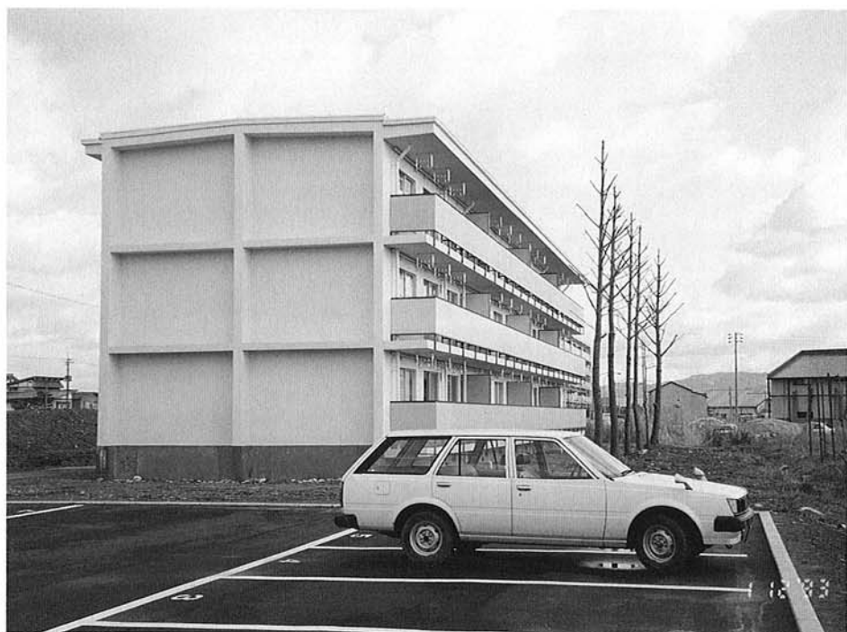
完成した越路ハイツ（本条地内）
