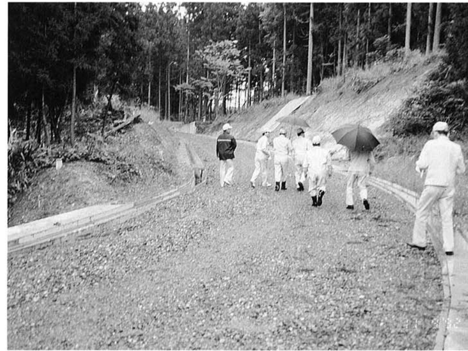
町道改良工事 東谷地内 (宇曾ヶ入り)
