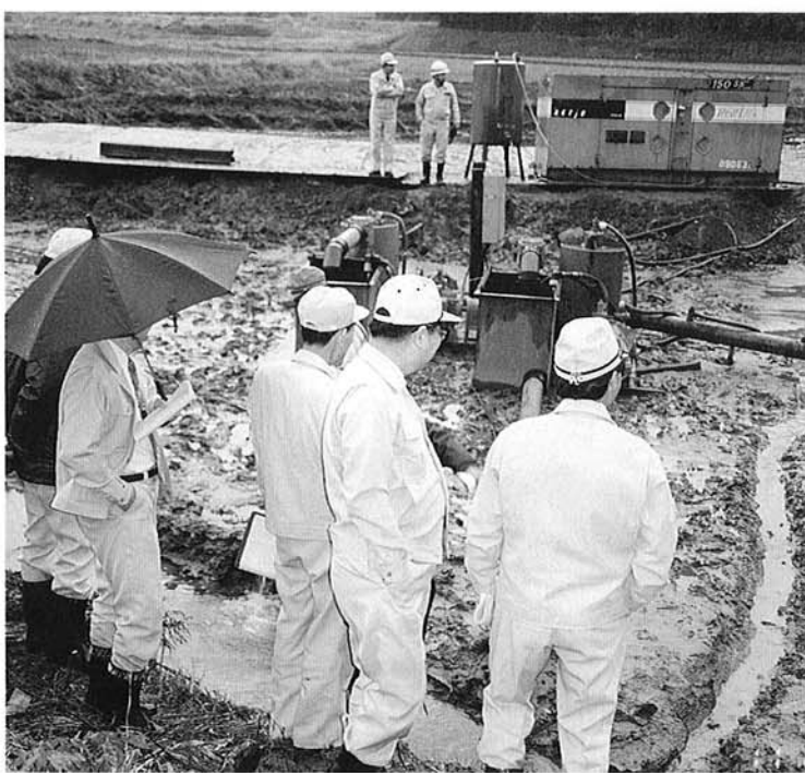
塚山農排水処理工事現場
