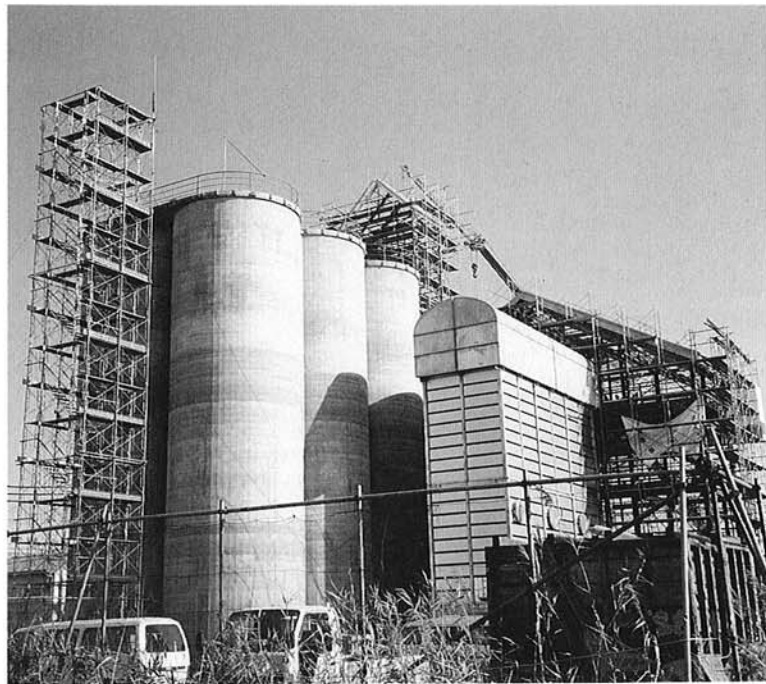
越路カントリー建設 第3号機
