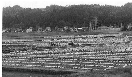
コストを下げる暗渠排水工事（浦地内）
