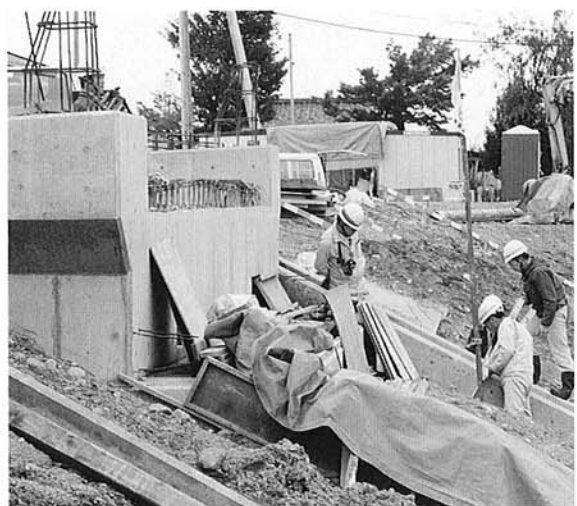
完成が待たれる常磐橋工事現場
