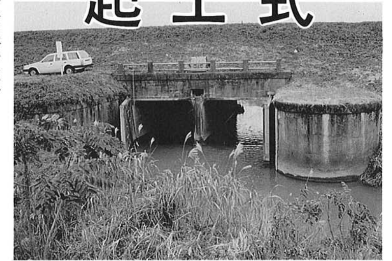
昭和9年に建設された須川水門は57年間の幕を閉じる
