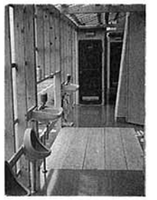
仮設便所が設置され喜ばれました
