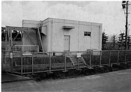
中沢ポンプ場 町の排水はここからポンプで浪海川を渡り処理場へ
