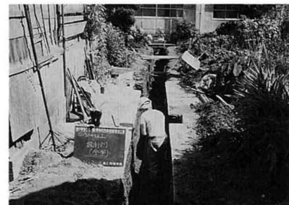
宅地内工事も早目に……
