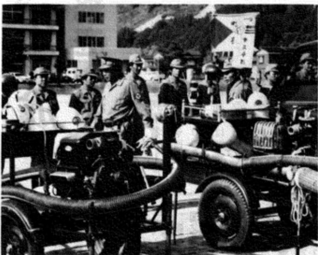
「機械器具」の点検
