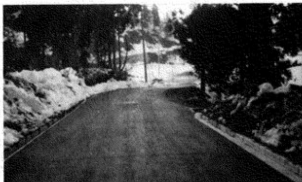
▶町道小相川線舗装完成
