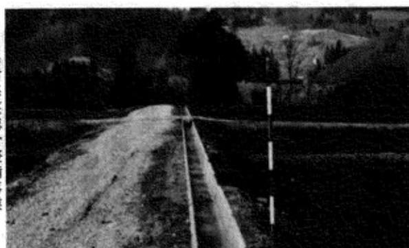
▶農村基盤総合整備事業用水路改良(上川地区)
