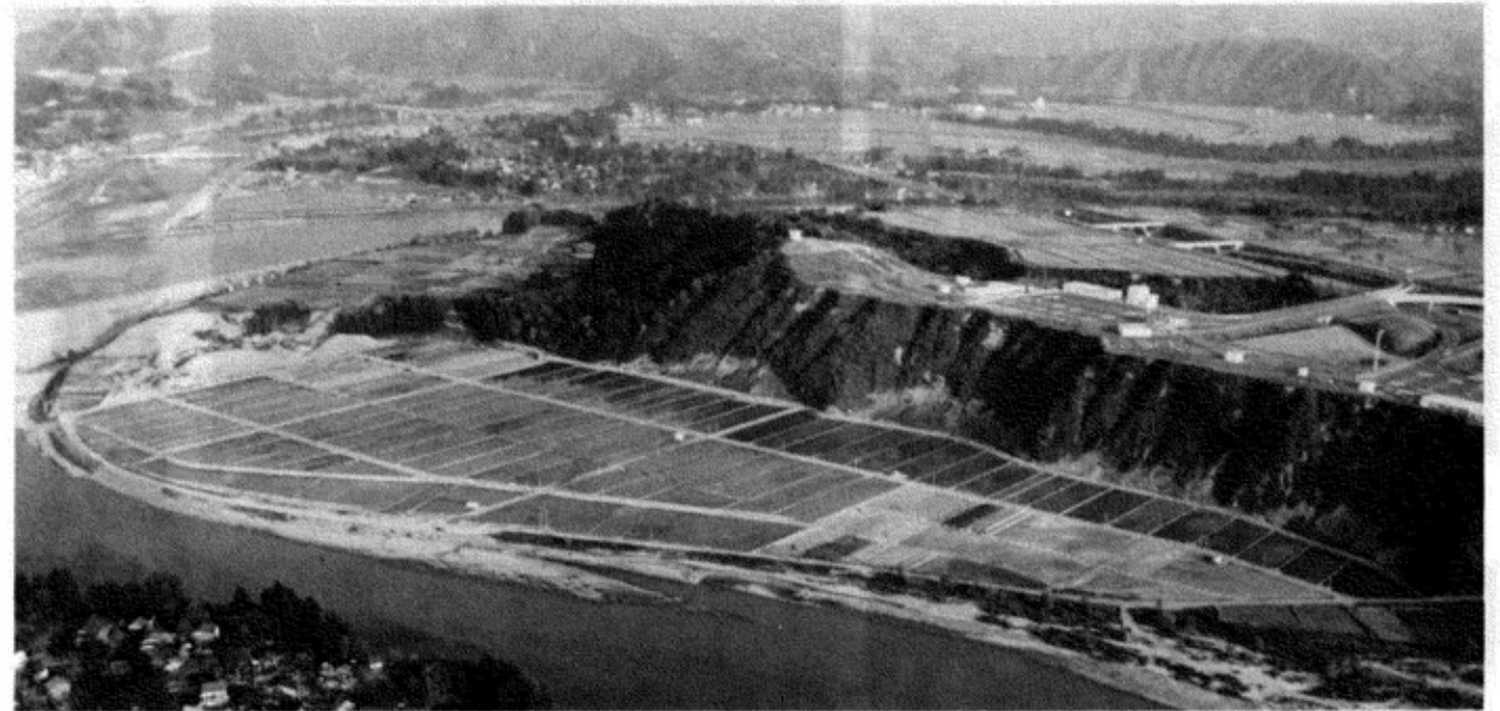
▲ 着々と農業基盤の整備が進む。西倉地区基盤総合整備事業（桑巻ホ場整備60年完成）
