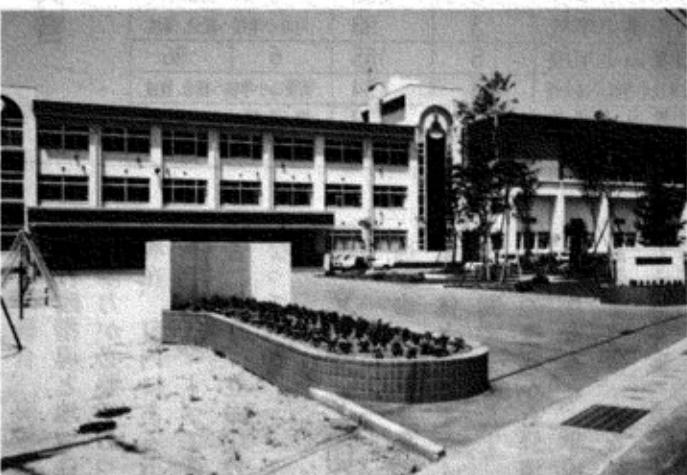
▲ 川口小大規模改修(普通教室棟) 体育館、食堂 61年12月完成
