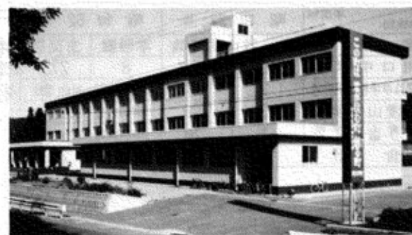
▲ 田麦山小新築 59年12月完成
