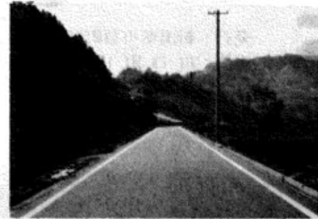
桑巻線改良舗装事業
