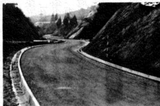
道路改良も進む
