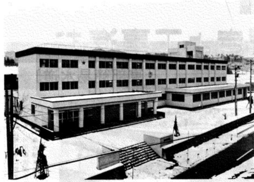
▲ 昨年12月完成された田麦山小学校
