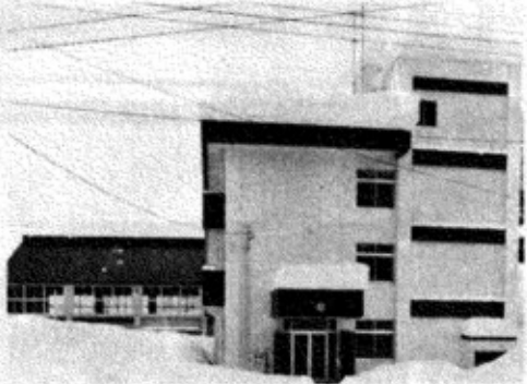
▶ 突貫工事により六年生は新校舎から集立てる木沢小学校
