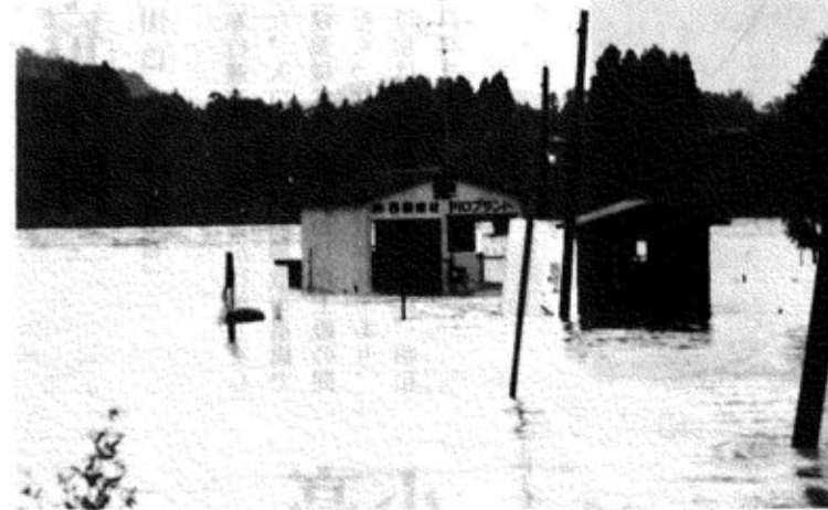
▲ 床上浸水した作業所(牛ヶ島)
