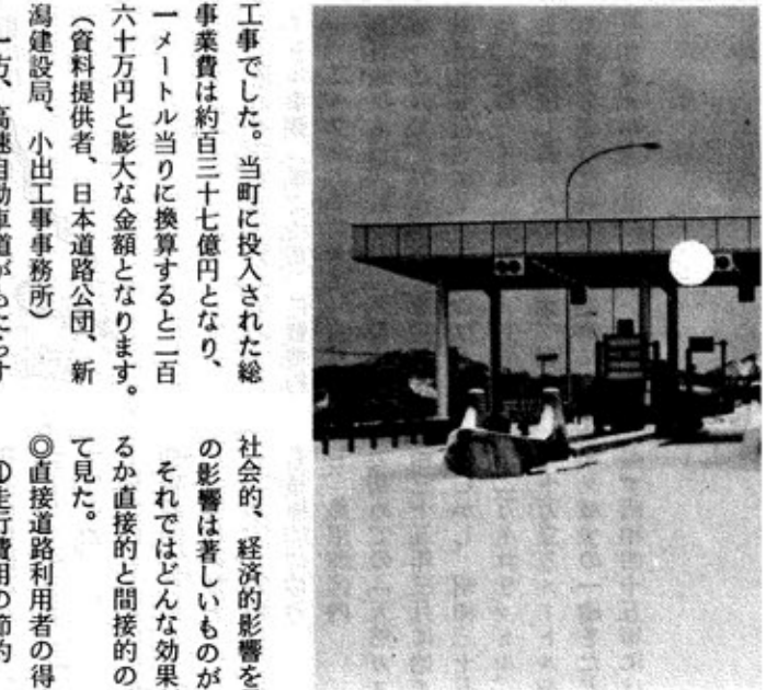
工事はすべて終了し静かに越後川口・C料金所
