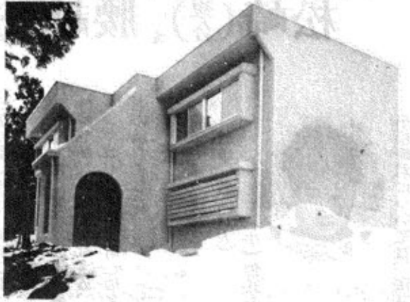
▲完成された木沢教員住宅 (昭和56年12月25日撮影)
