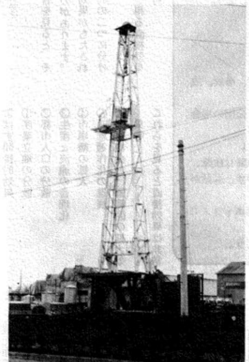
8月から試掘を始める「新田麦山SK1号井」に設置される最新鋭掘削装置「110UE」高さが53mにもなる。 〔資料提供者 石油資源開発株式会社長岡鉱業所〕
