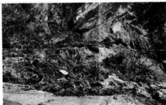
▲小高 被災現場
