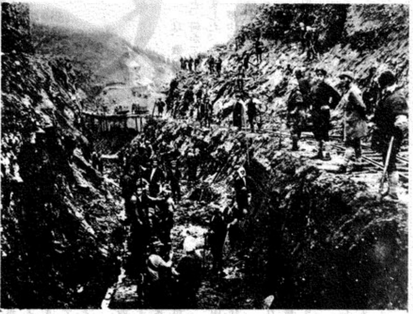
上越北線鉄道工事(天納地内) 当時の工事はほとんど人力で行った掘り割りの工事が進む大字相川地内から上り方面に向っての工事状況(大正初期)
