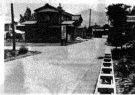
改良工事の終わった原新田の排水路
