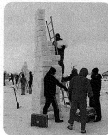
型枠で作った雪を積み重ねた だーすけ東部
