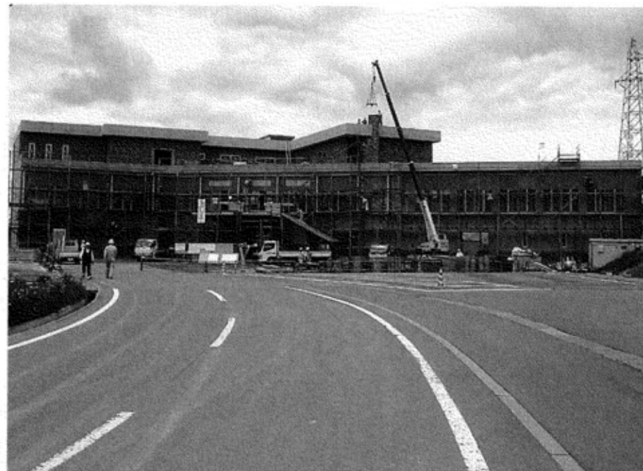
▲完成間近なえちご川口ホテルサンローラ宿泊棟
