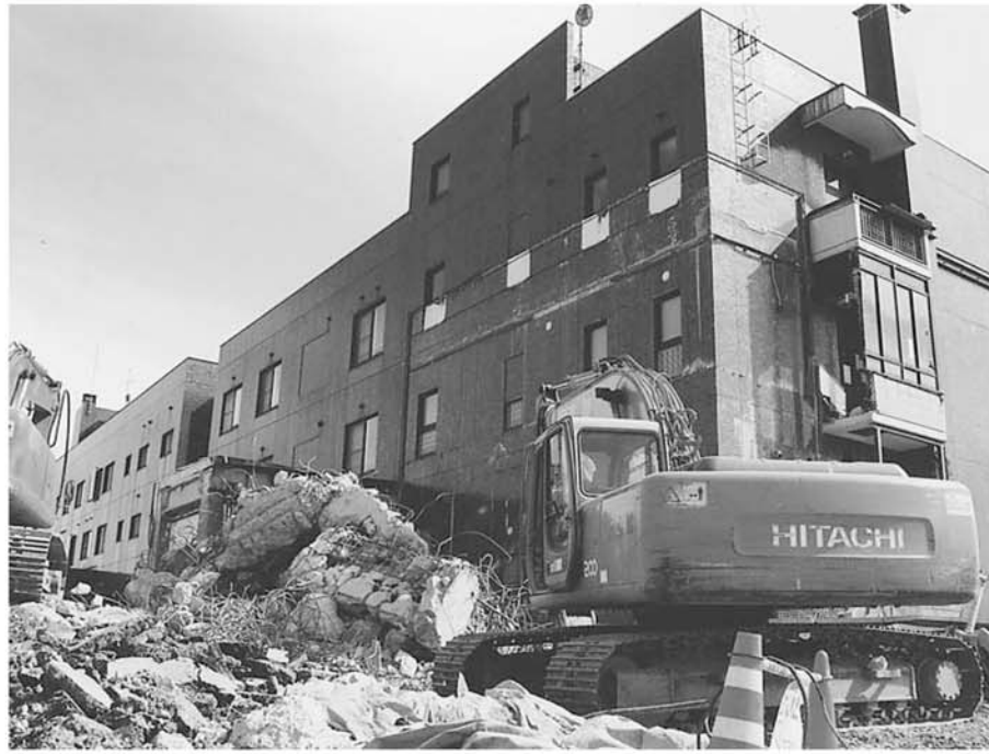
▲解体し新たに建設することが決定したホテル蒼丘 (写真は旧温泉棟の解体作業の状況、5月20日撮影)
