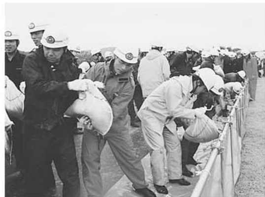
▲改良積み土のう工法
