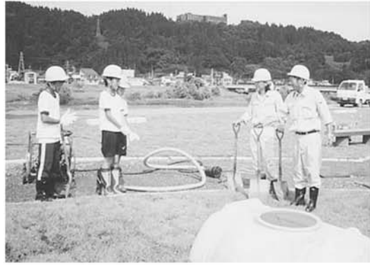
「ここではどんな工事をしているんだろう？」
