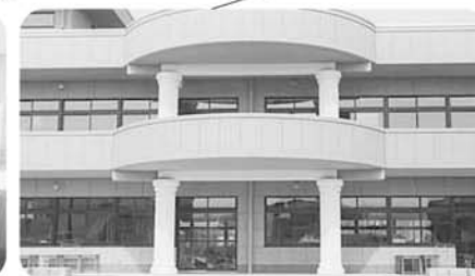
屋外ステージ 野外ステージには、化粧柱（ギリシャ建築風）を設置し野外での多目的活動に利用できます。
