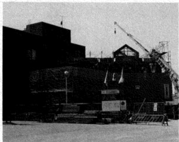
▲急ピッチで進む温泉施設建設工事
