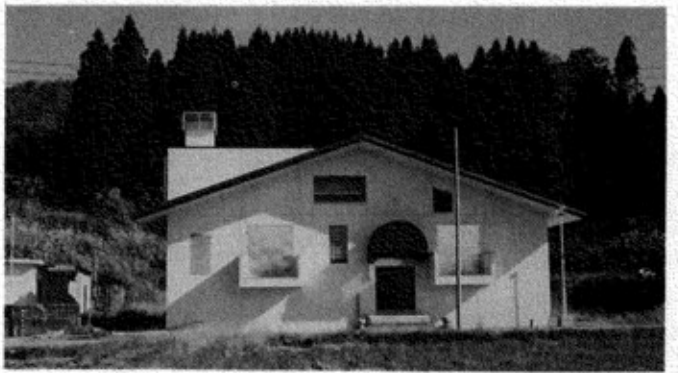
▲公共下水道 牛ヶ島中継ポンプ場
