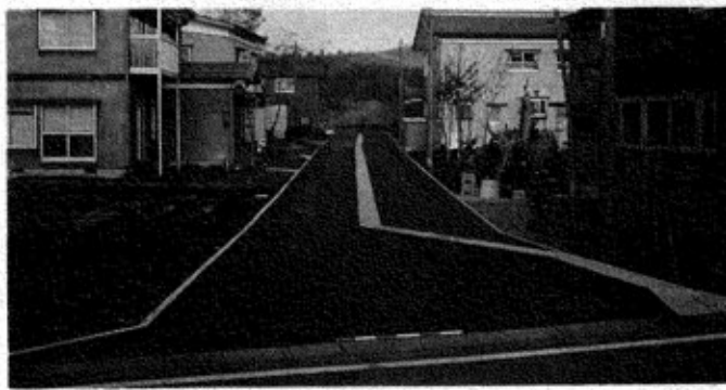
▲道路整備「舗装」
