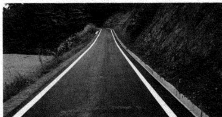
▲「日影農道改良舗装」木沢地区
